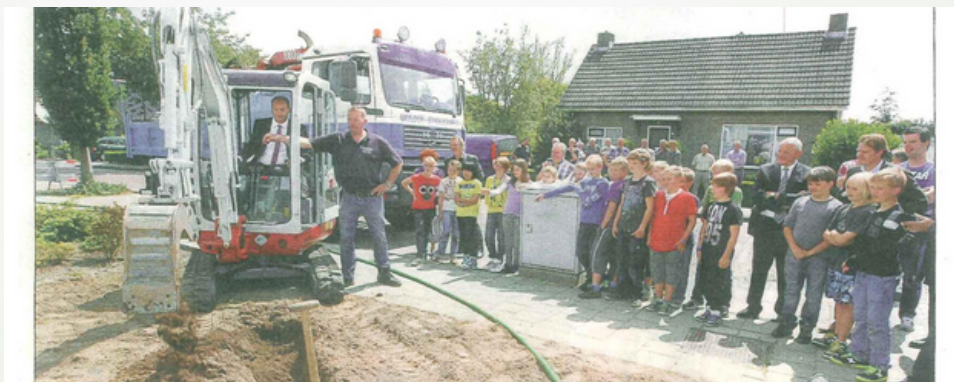
artikel uit De Stentor: Schoolkinderen kijken toe hoe gedeputeerde Theo Rietkerk met een graafmachine een schep zand wegneemt voor de aanleg van snel internet in Hoonhorst.
